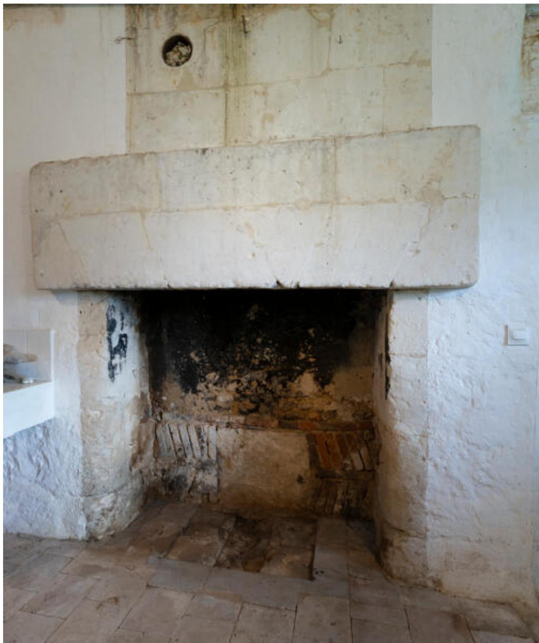
Ancien logis du chapelain : cheminée de la seconde pièce.
