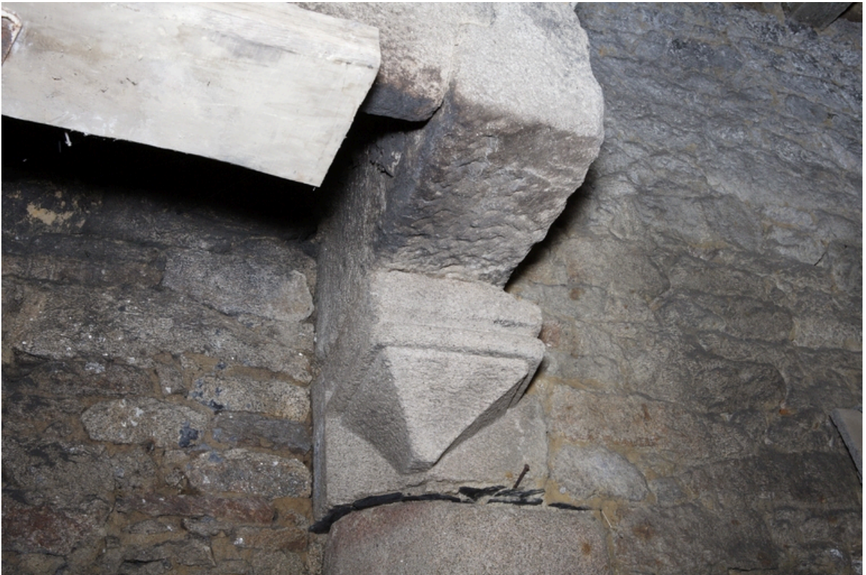
Bâtiment ouest. Détail du corbeau de droite de la cheminée.
