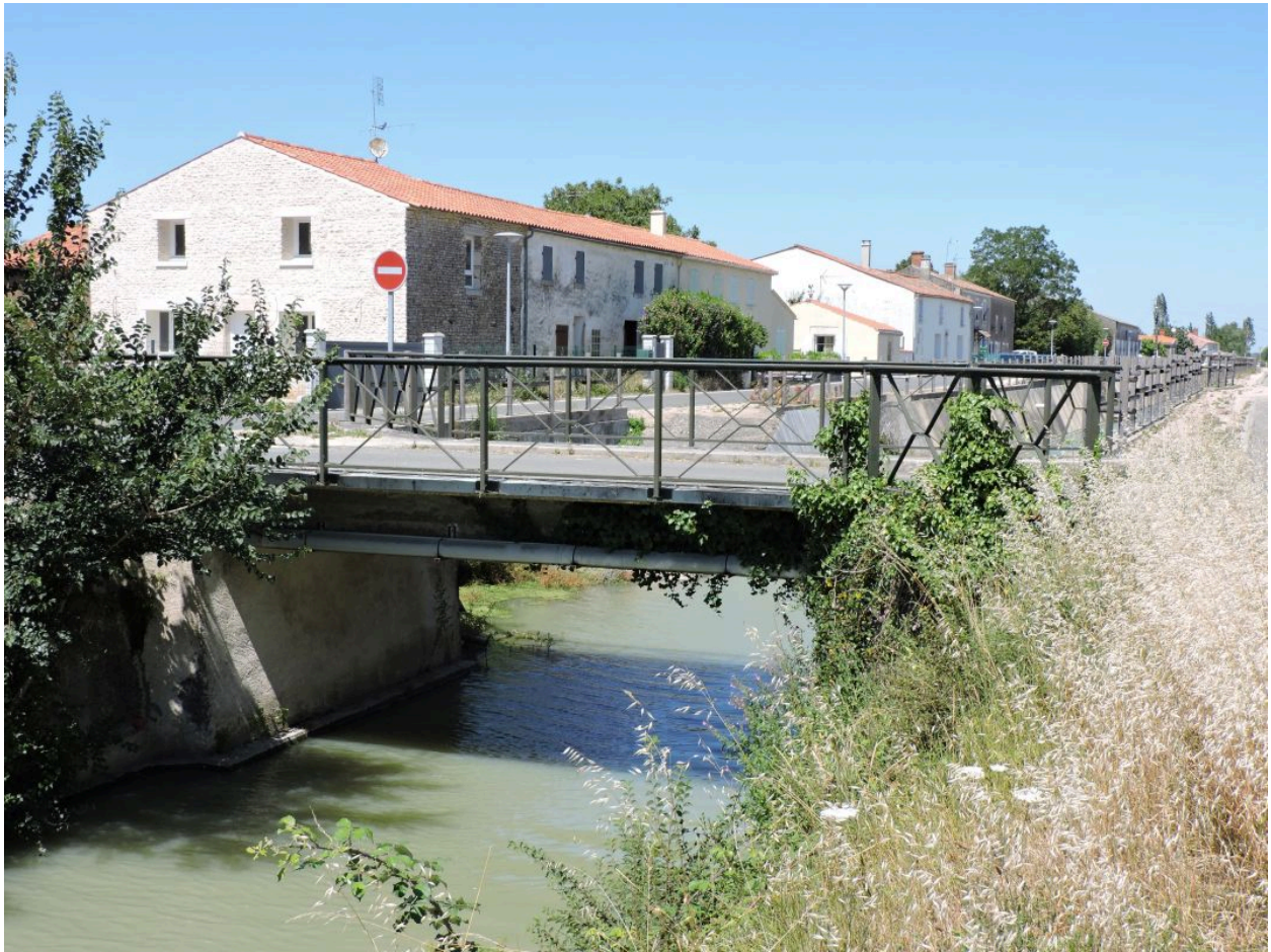
Le pont vu depuis l'aval, au sud.
