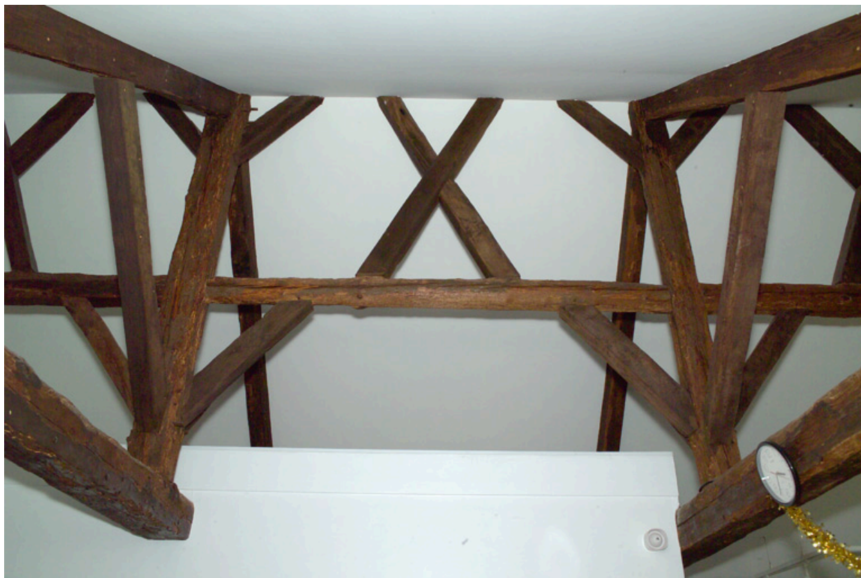
Comble, détail de charpente.
