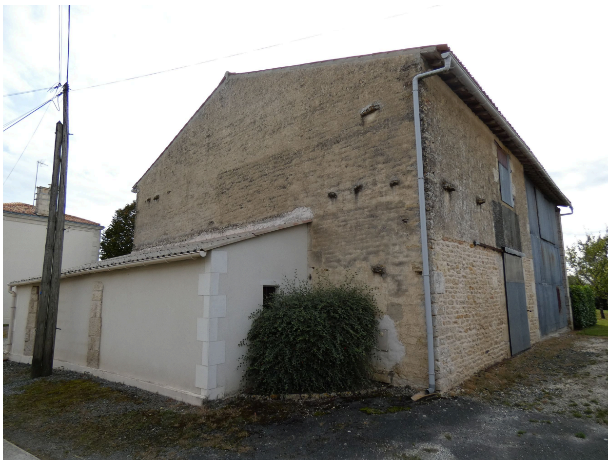
Les dépendances à l'ouest, vues depuis le nord-ouest.
