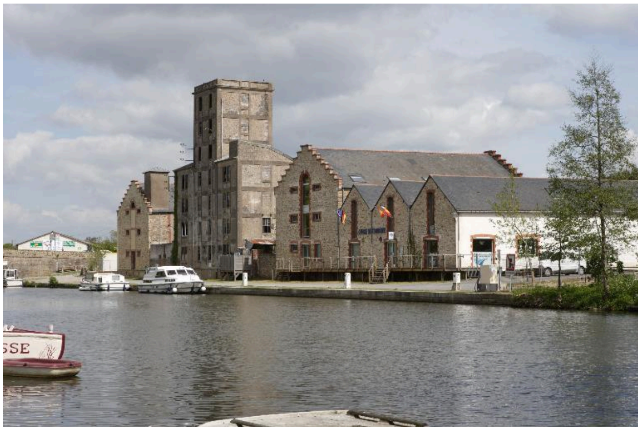
Minoterie et bâtiments de stockage, vue du bassin.
