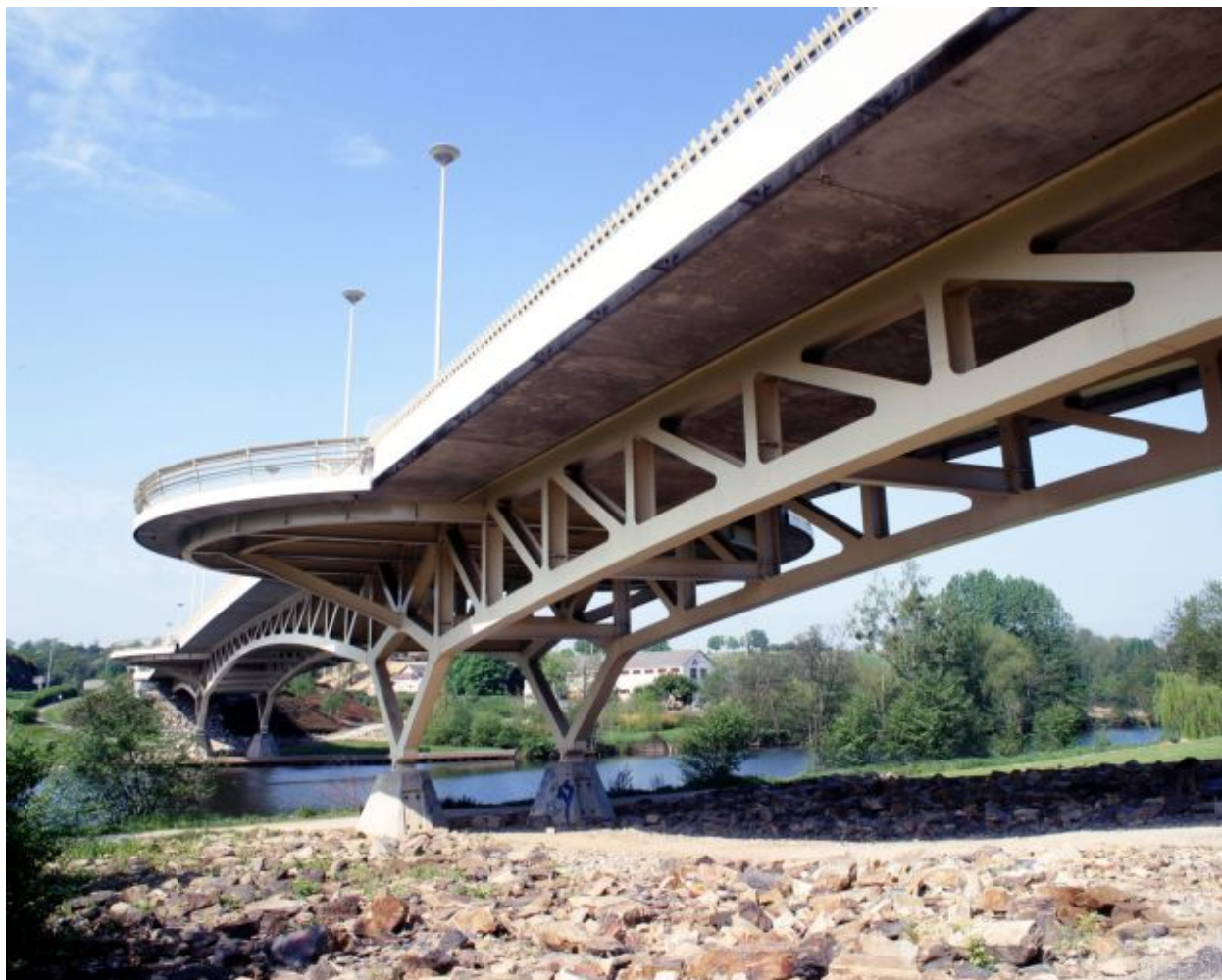
Vue d'ensemble, depuis la rive droite.
