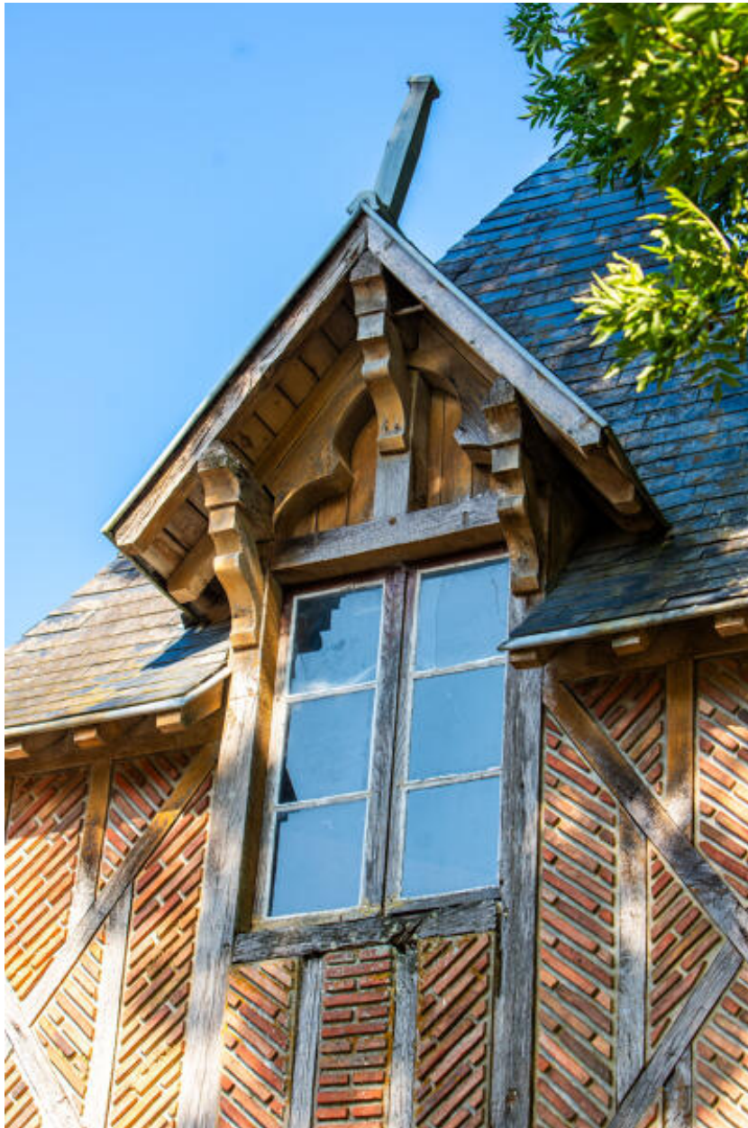
La tour château d'eau, détail d'une lucarne.
