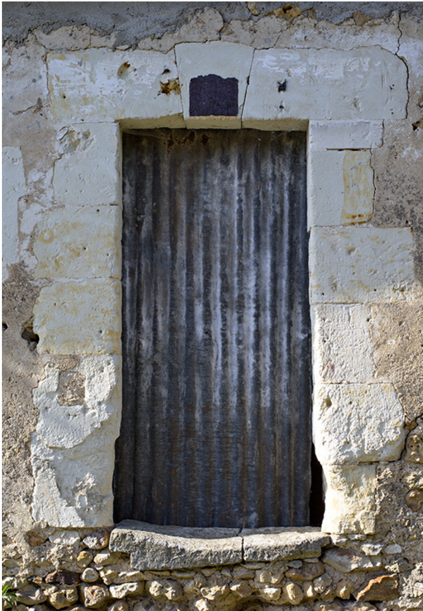
Façade sud, détail : la porte (côté gauche).
