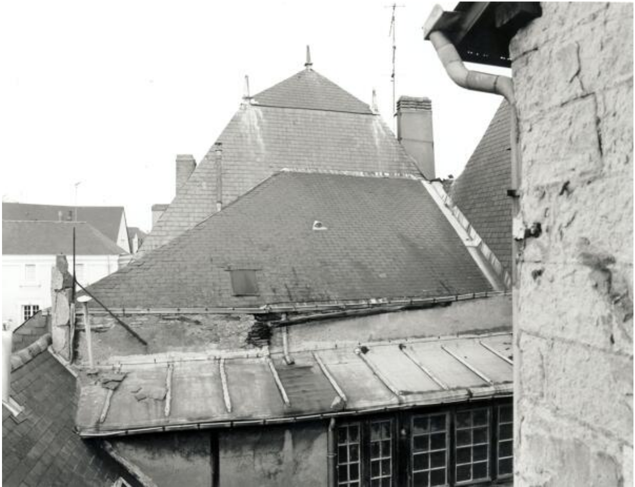
Courette enclavée entre les bâtiments conventuels le long de la rue de la Censerie : face nord, partie haute.
