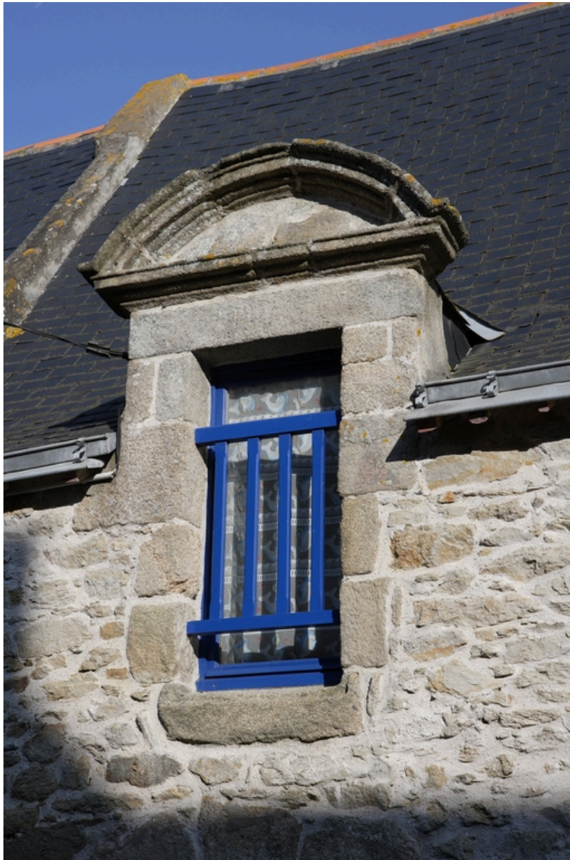
Détail de la lucarne du n° 17 rue du Four.
