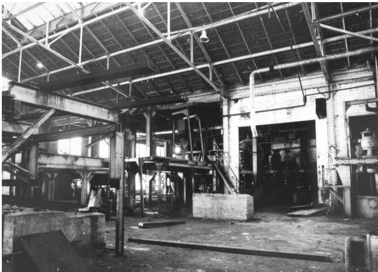
Nouvelle usine. Bâtiment non précisé. Atelier de fabrication des sucres granulés.
