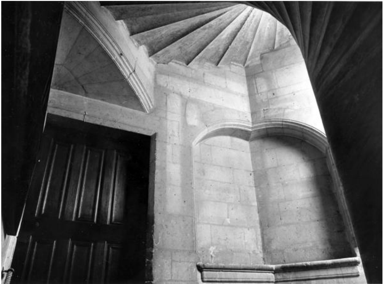
Cage de l'escalier, deuxième révolution, avec porte d'accès au premier étage du corps de logis droit.
