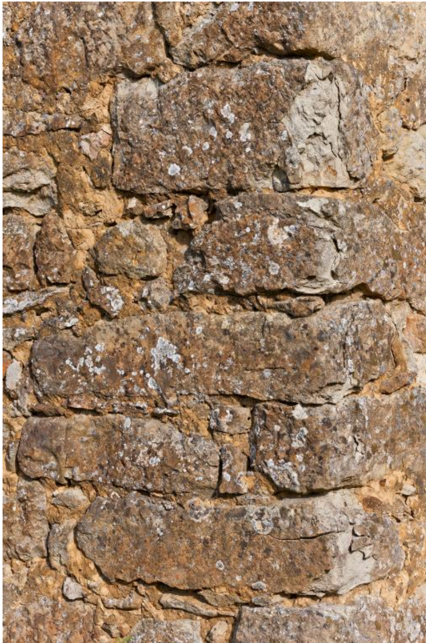
La Borde. Détail de l'une des chaînes d'angle en grès de la grange.
