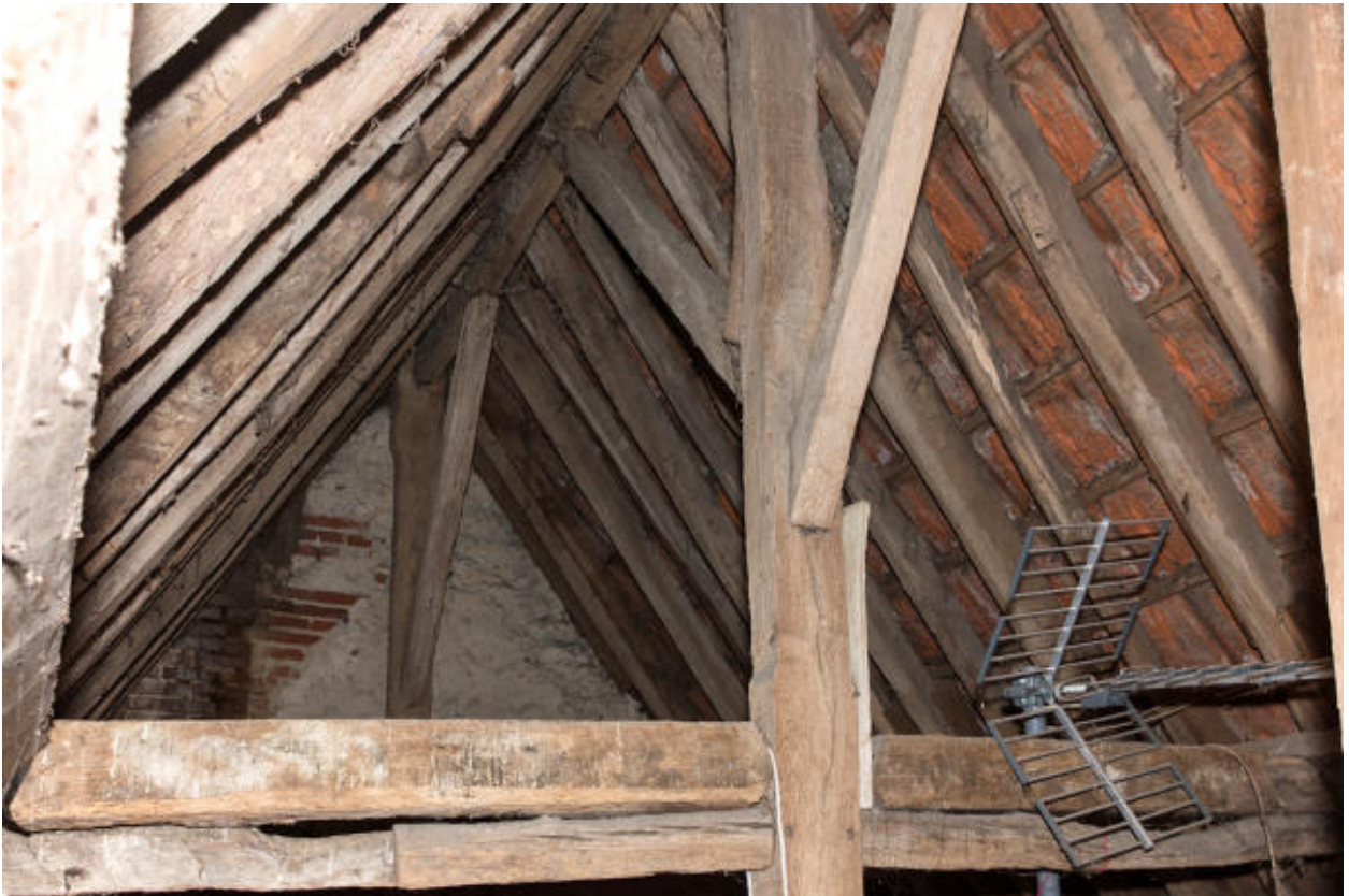
Vue du poinçon central de la charpente.
