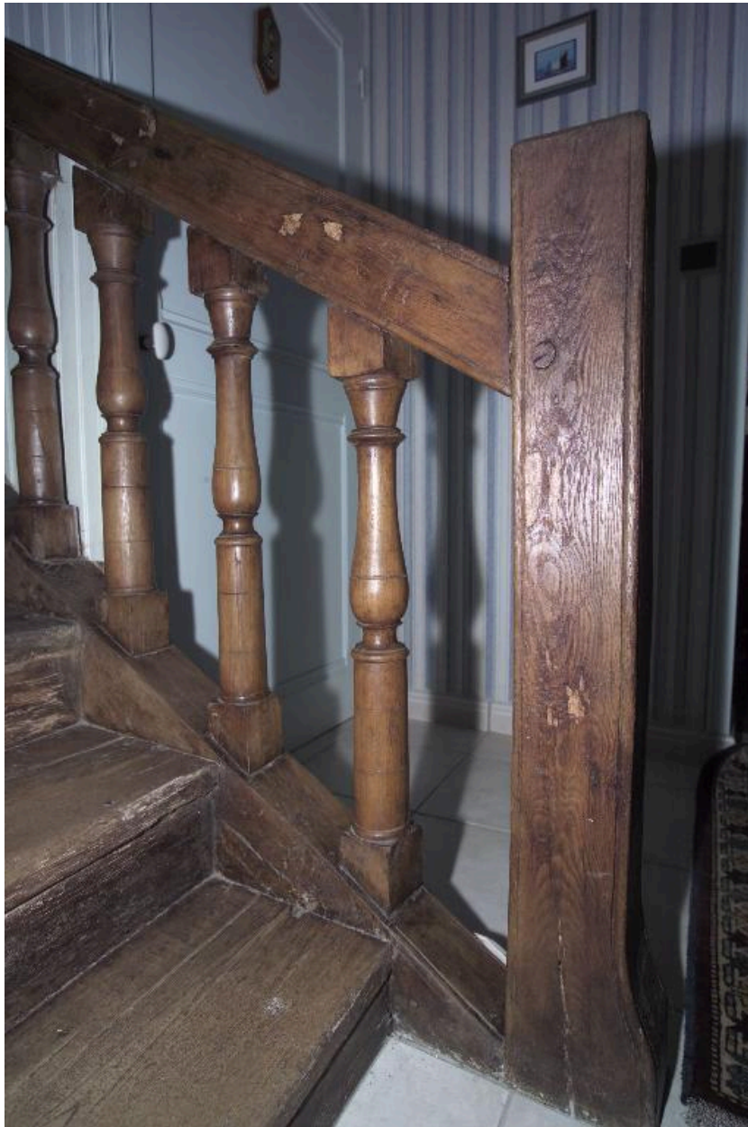
L'escalier, détail des balustres.
