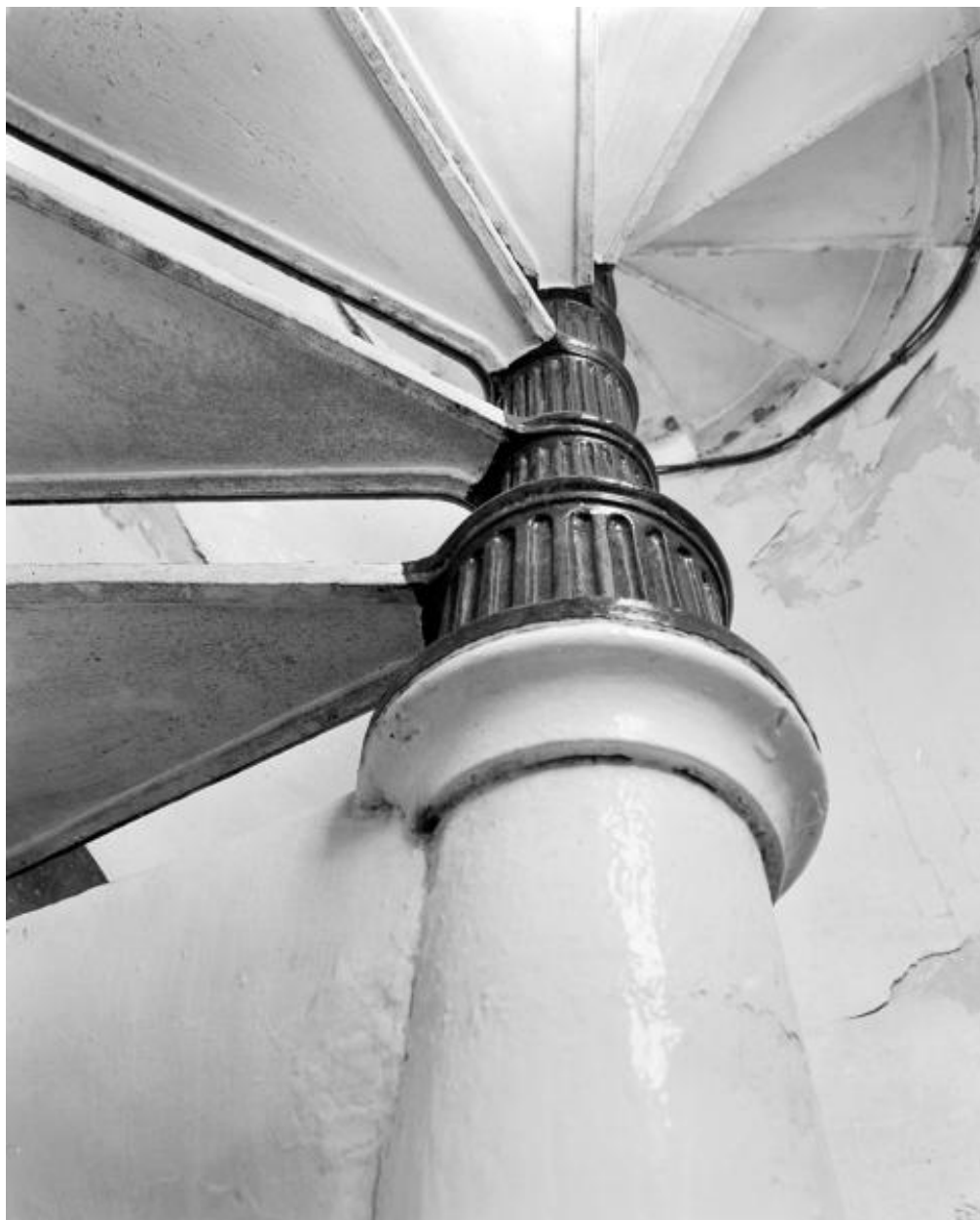
Détail de la tourelle du phare.
