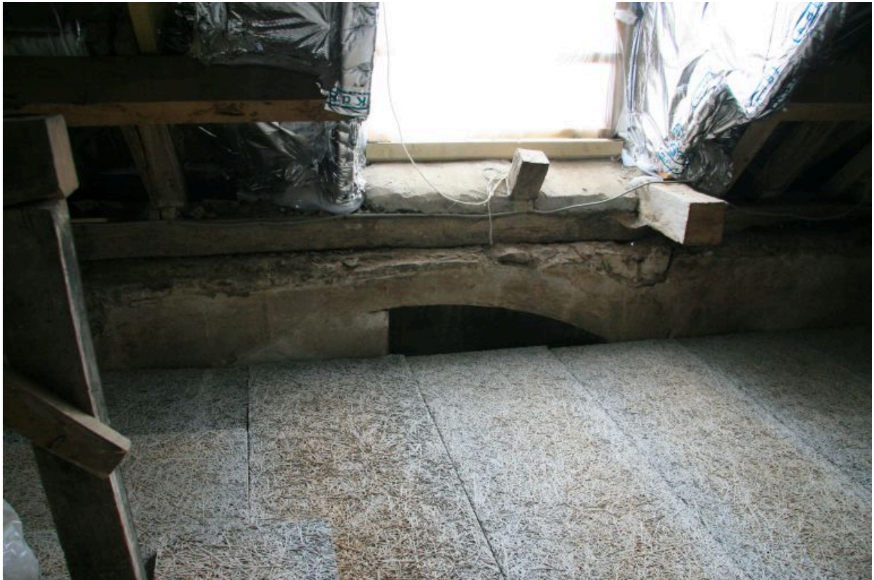
La maison, plancher du grenier remanié : linteau de baie en anse-de-panier coupé.
