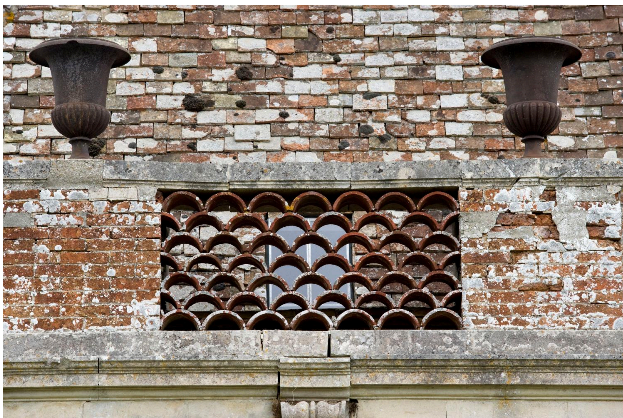
Détail du garde-corps du pignon sud des communs.
