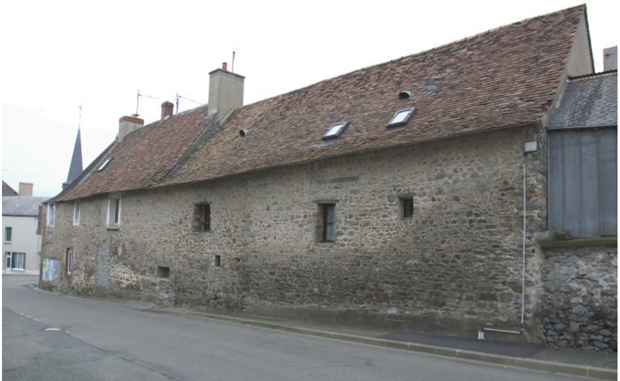
Vue depuis la rue des écoles au sud-ouest.
