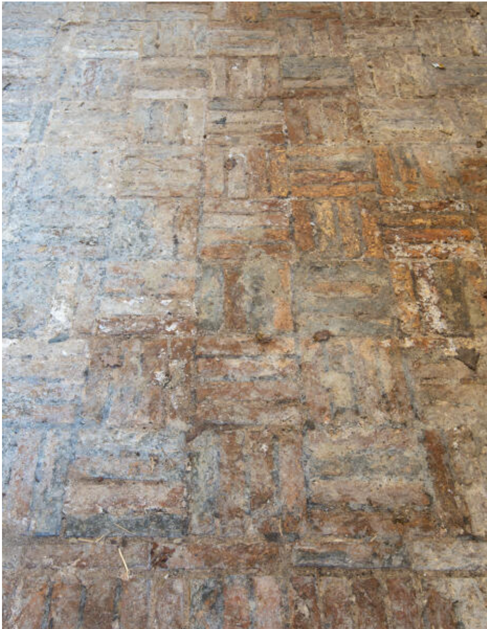
L'écurie, détail du sol.
