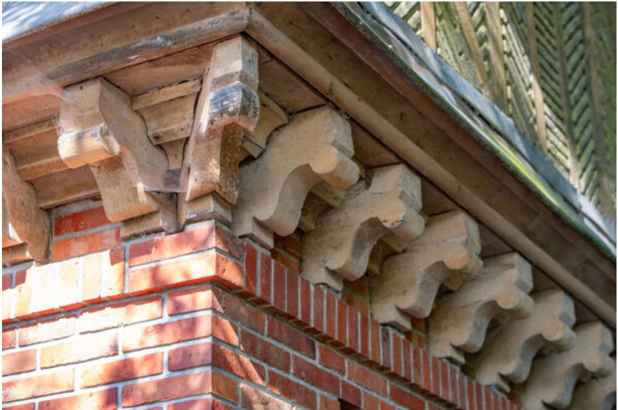
La tour château d'eau, détail de l'encorbellement.
