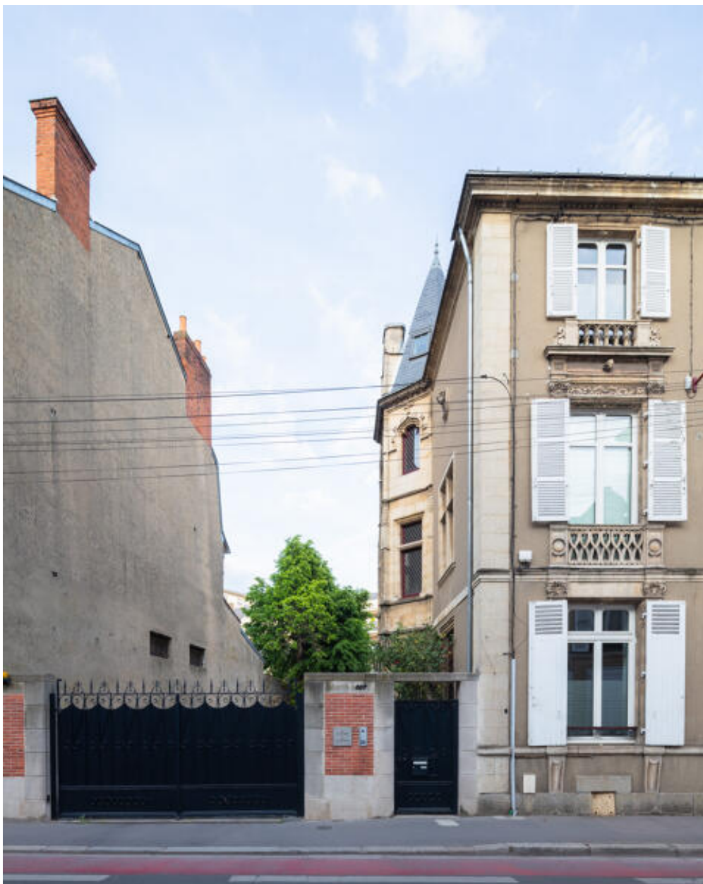
Vue du portail jouxtant la maison.
