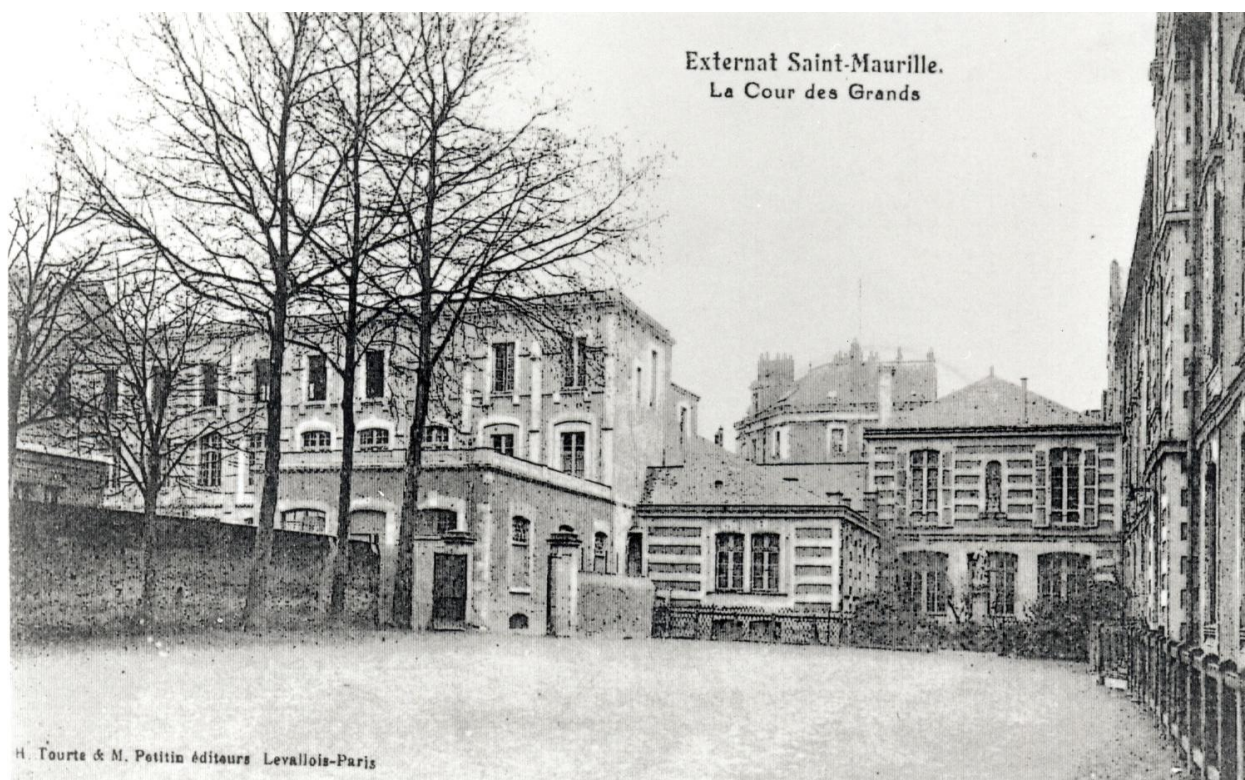
Externat Saint-Maurille. La Cour des Grands : vue de la cour nord depuis l'est, avec le bâtiment de classes des moyens de 1924 et le revers des bâtiments de la porterie en arrière-plan, carte postale, 2e quart 20e siècle.
