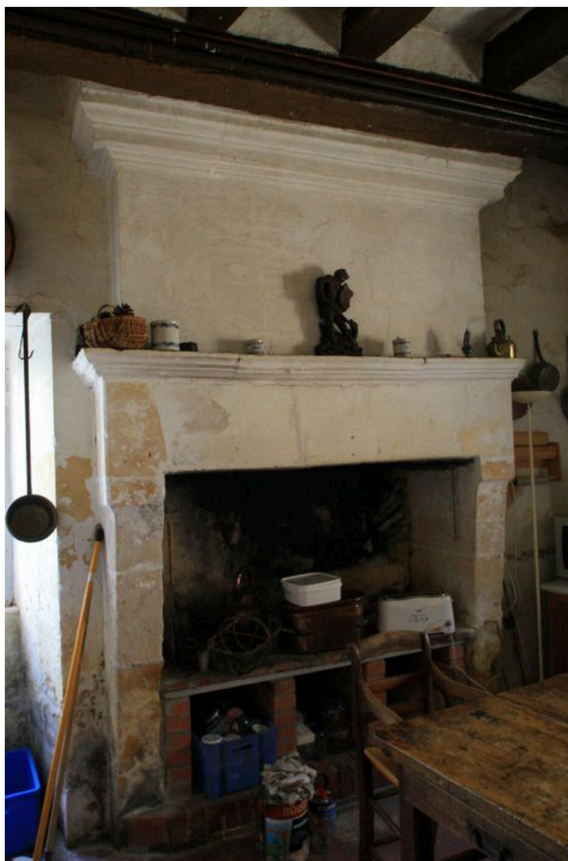
Rez-de-chaussée, cuisine : cheminée du XVIIIe siècle.
