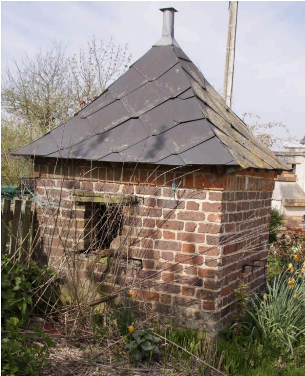
Puits en brique noire. La Haute Claie.
