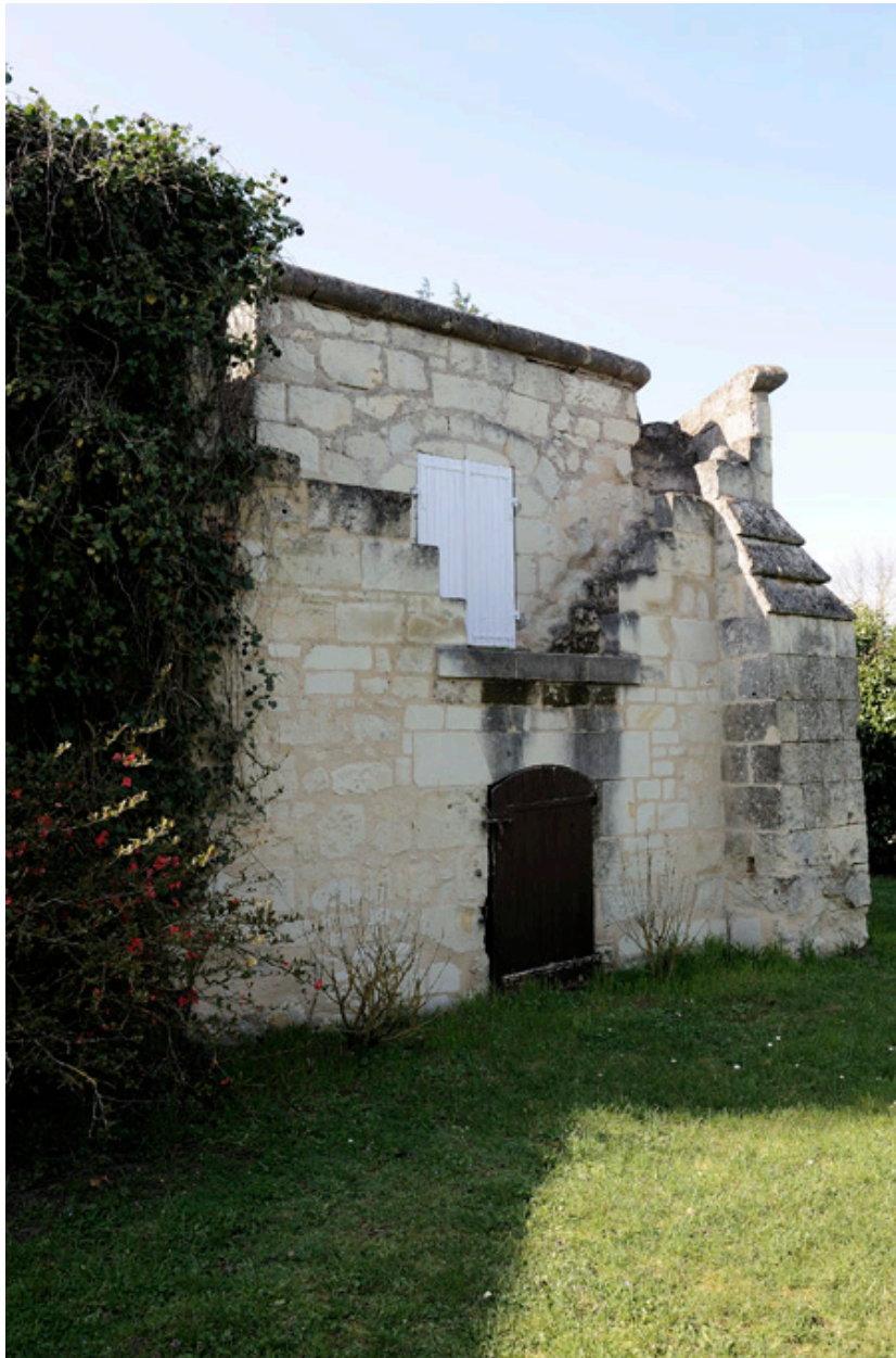
Moulin Picard : façade est.
