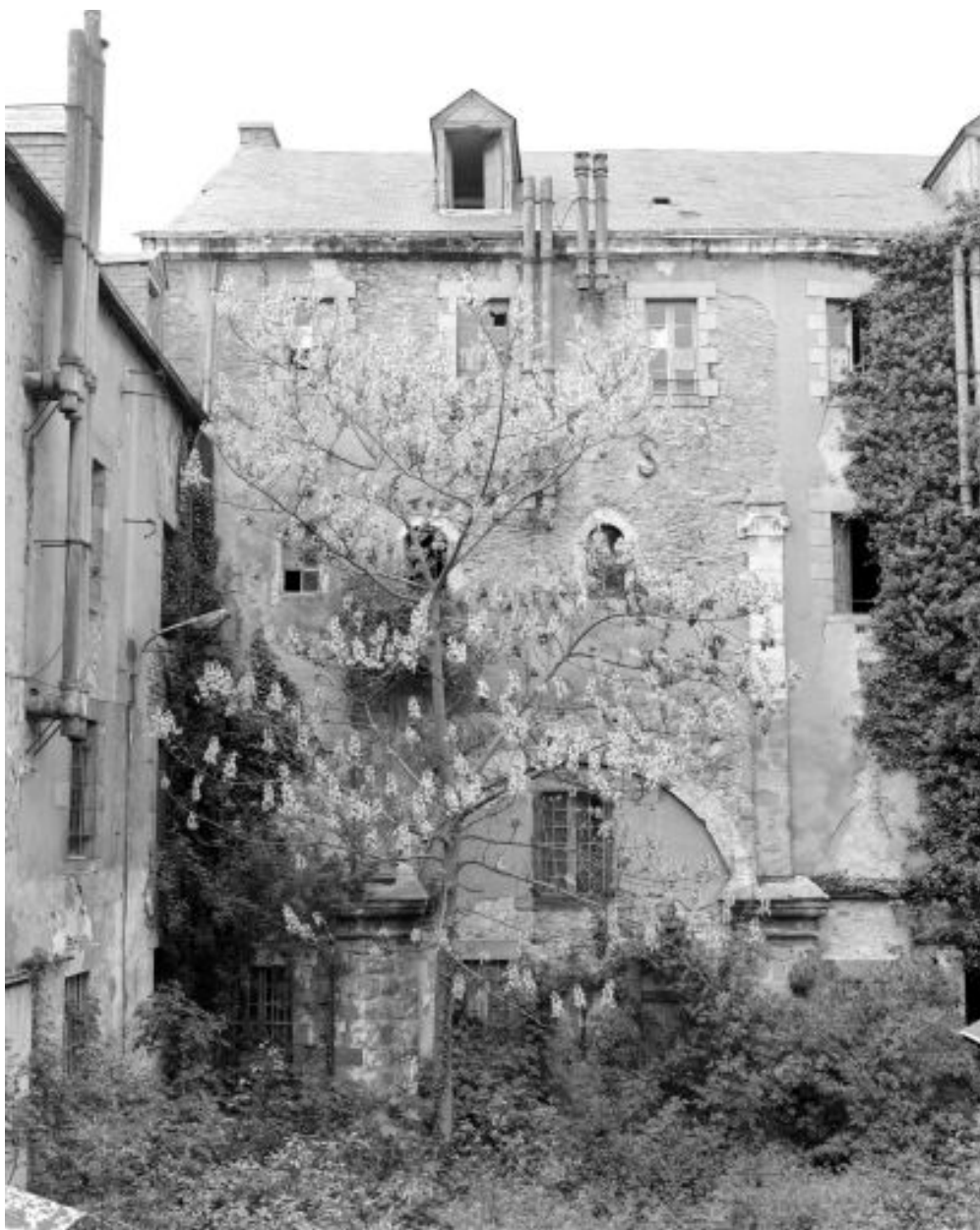
Couvent, élévation nord-ouest sur cour : vue d'ensemble.
