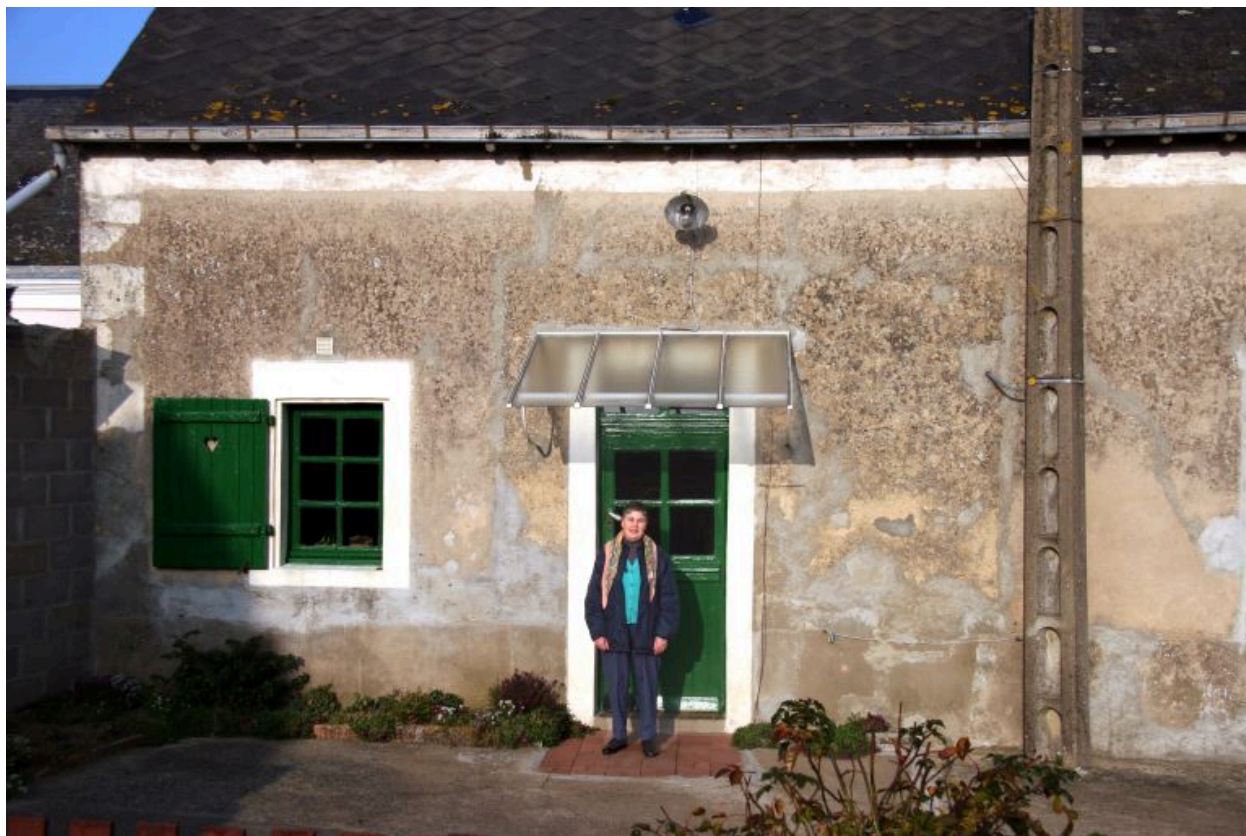
Façade antérieure de la maison.
