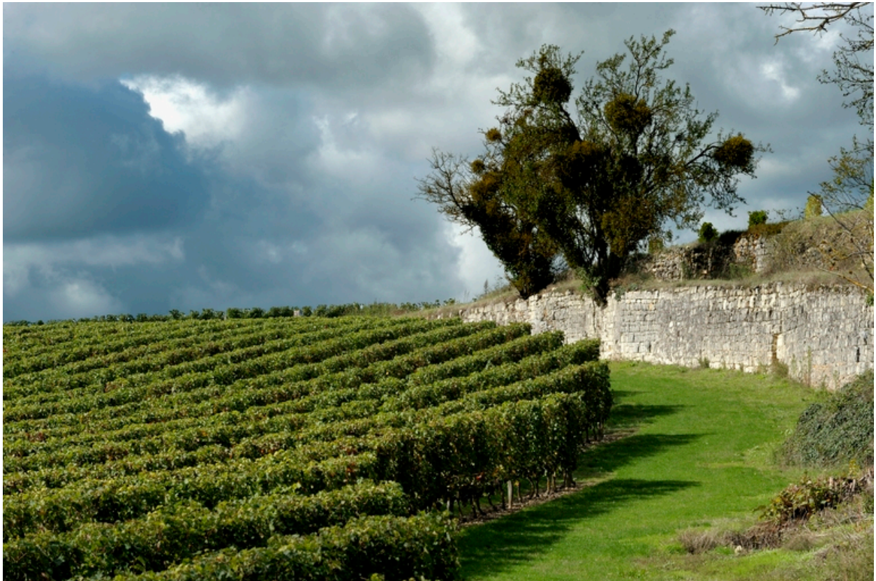
Le mur de soutènement du chemin des Bournais, sur le plateau viticole.
