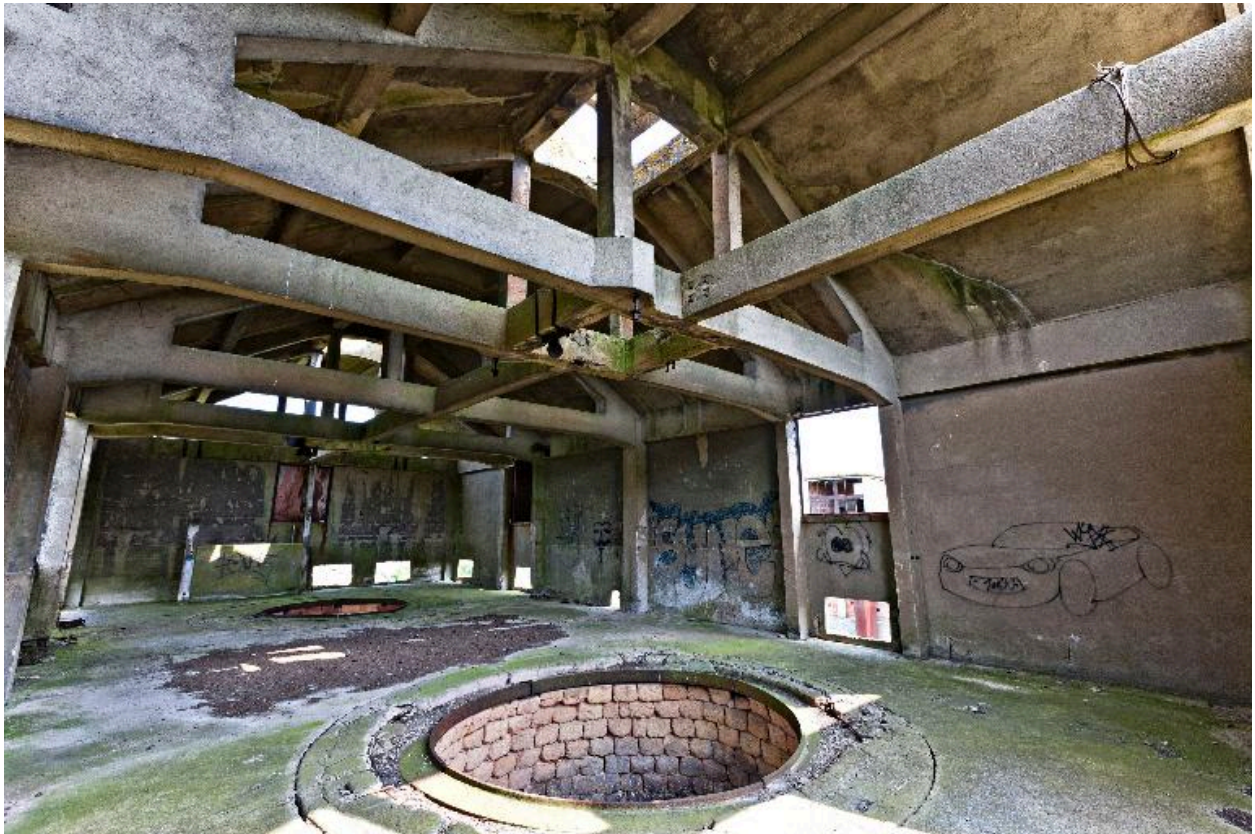
Plate-forme supérieure de chargement avec des fermes en béton armé.
