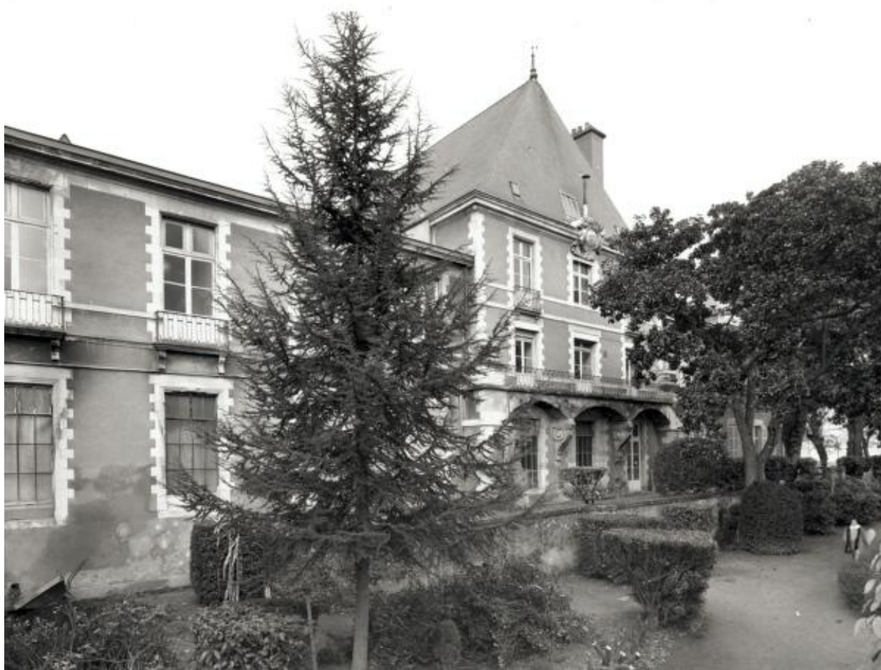
Aile est du cloître et son pavillon nord : façade est.
