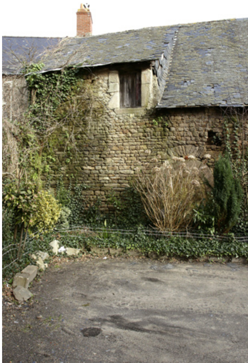
Elévation nord de la dépendance avec porte murée.
