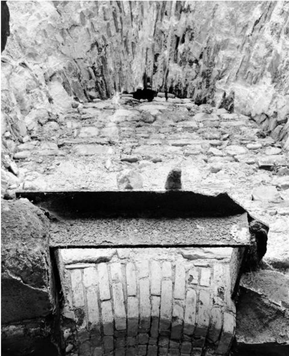
Vue de bas en haut depuis la voûte segmentaire du soubassement du fond de l'ébraisoir central en canonnière muré lors de la deuxième campagne et goulotte de chargement des wagonnets en fonte, massif des fours, partie est, fours de la Tranchée, Montjean-sur-Loire.
