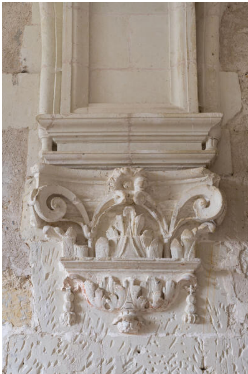
Chapelle latérale : retombée de voûte.
