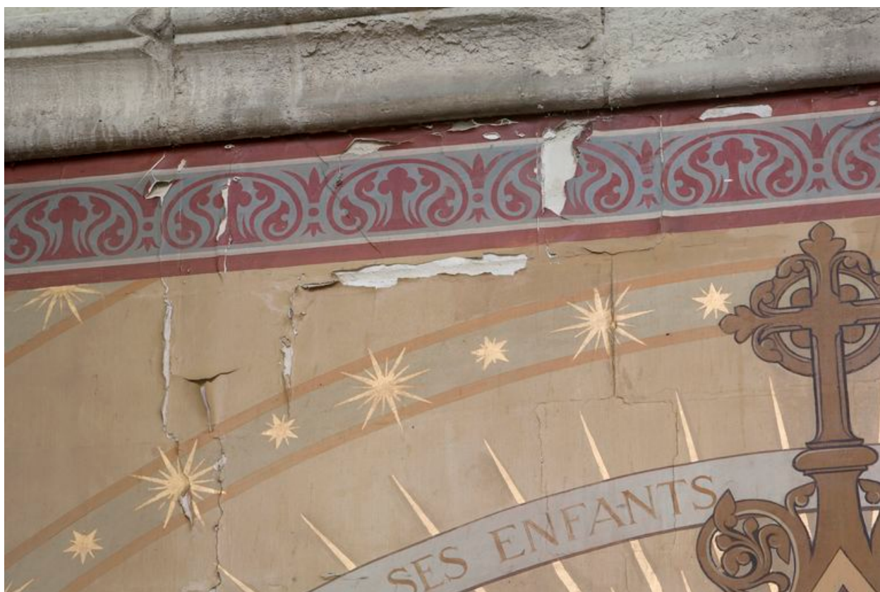
Nef, deuxième chapelle nord. Monument aux morts : détail de la partie supérieure du monument endommagée par des infiltrations d'eau.
