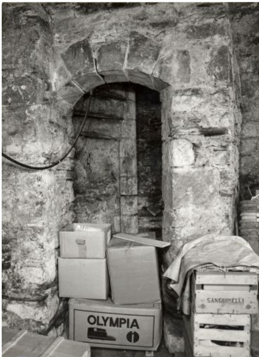
Logis postérieur, sous-sol, mur droit : cage de l'escalier en vis.
