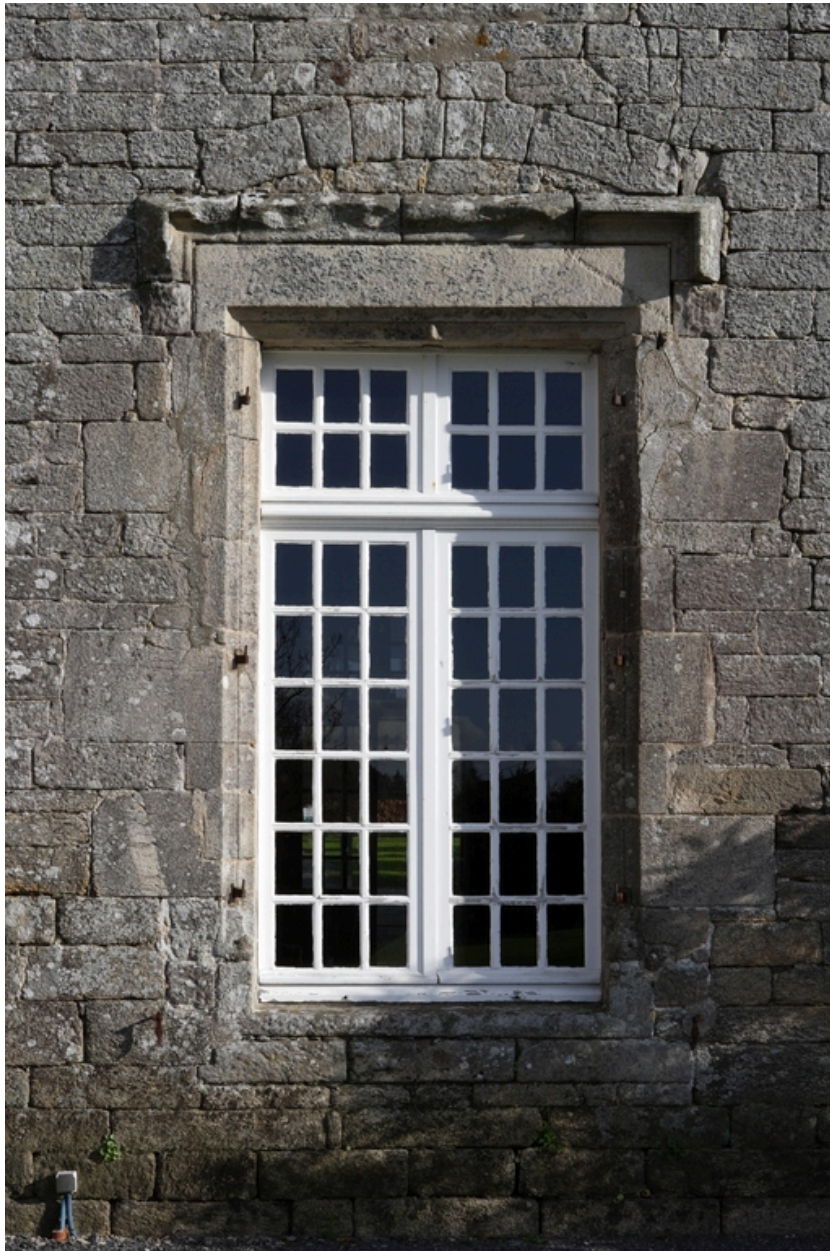
Logis. Aile est. Rez-de-chaussée. Façade ouest. Croisée.
