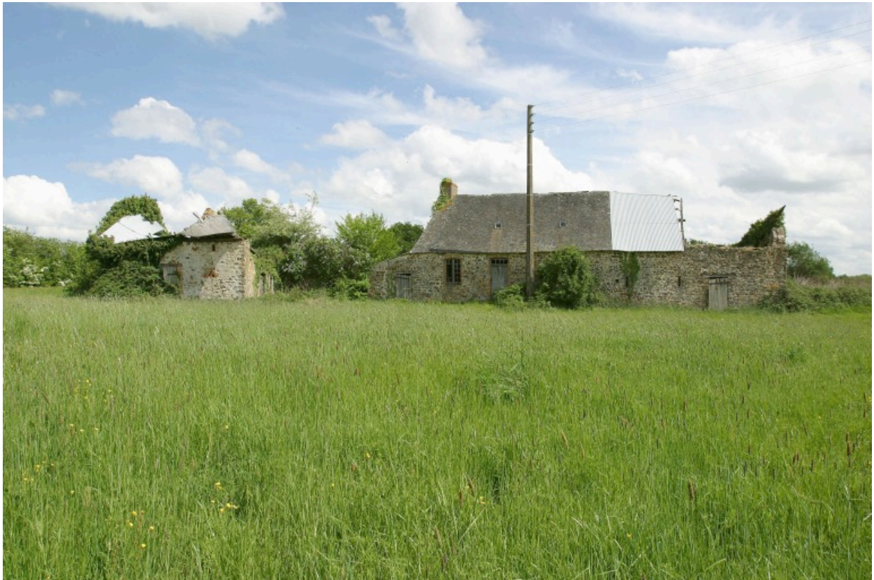
Vue d'ensemble depuis l'ouest.
