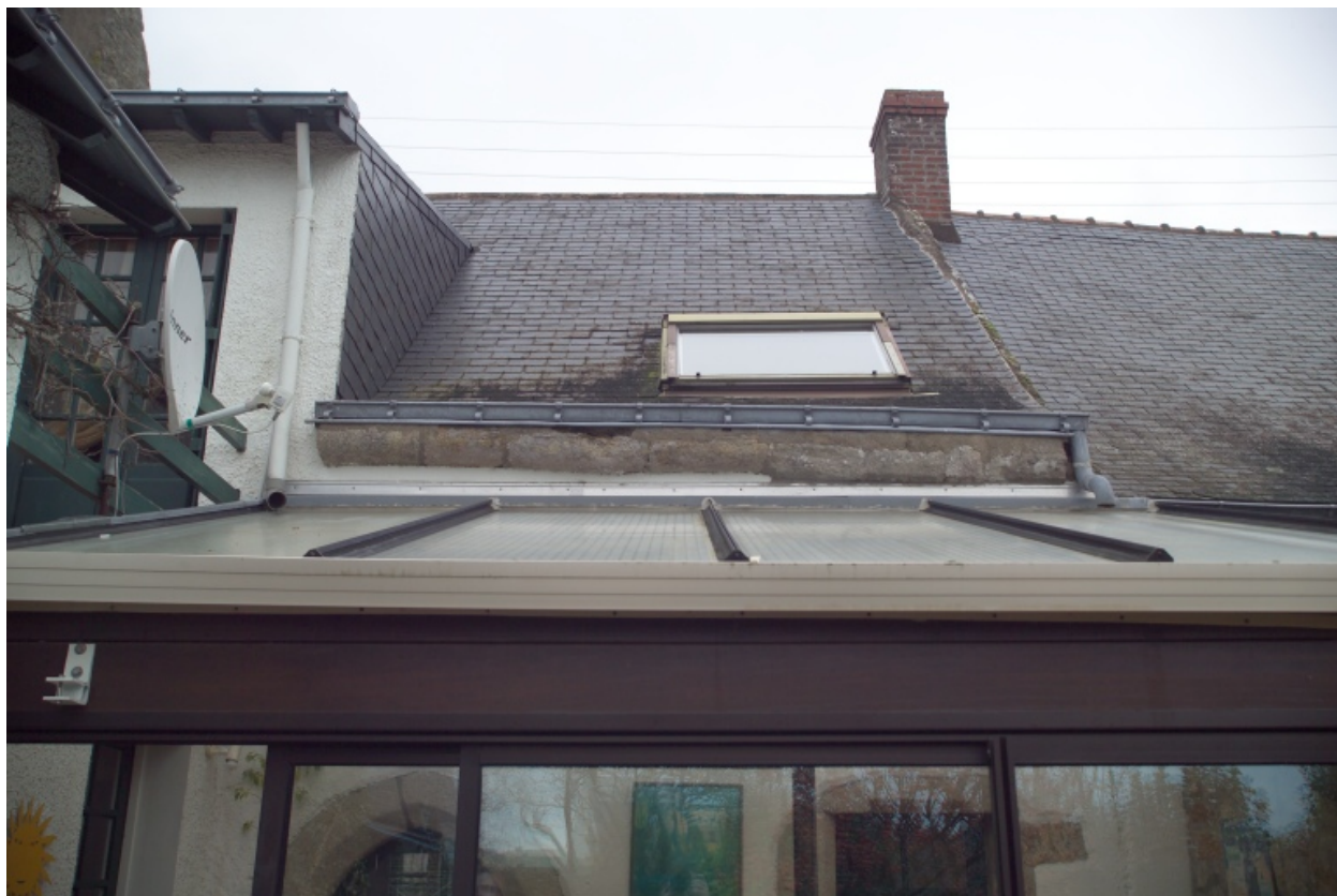
Détail de la corniche sur la façade postérieure.
