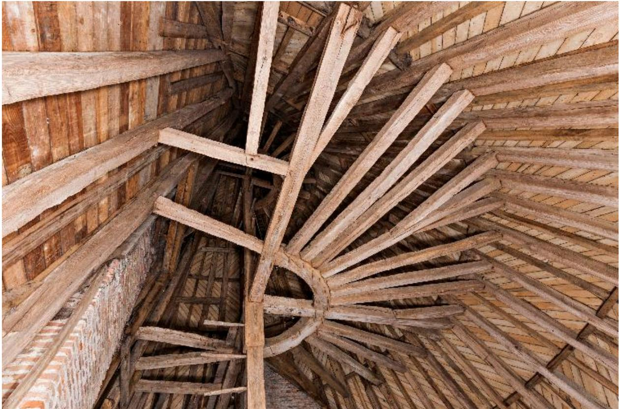
La charpente de la tour nord vue de dessous depuis le deuxième niveau de charpente : les trois niveaux supérieurs délimités par l'enrayure centrale et l'enrayure supérieure.
