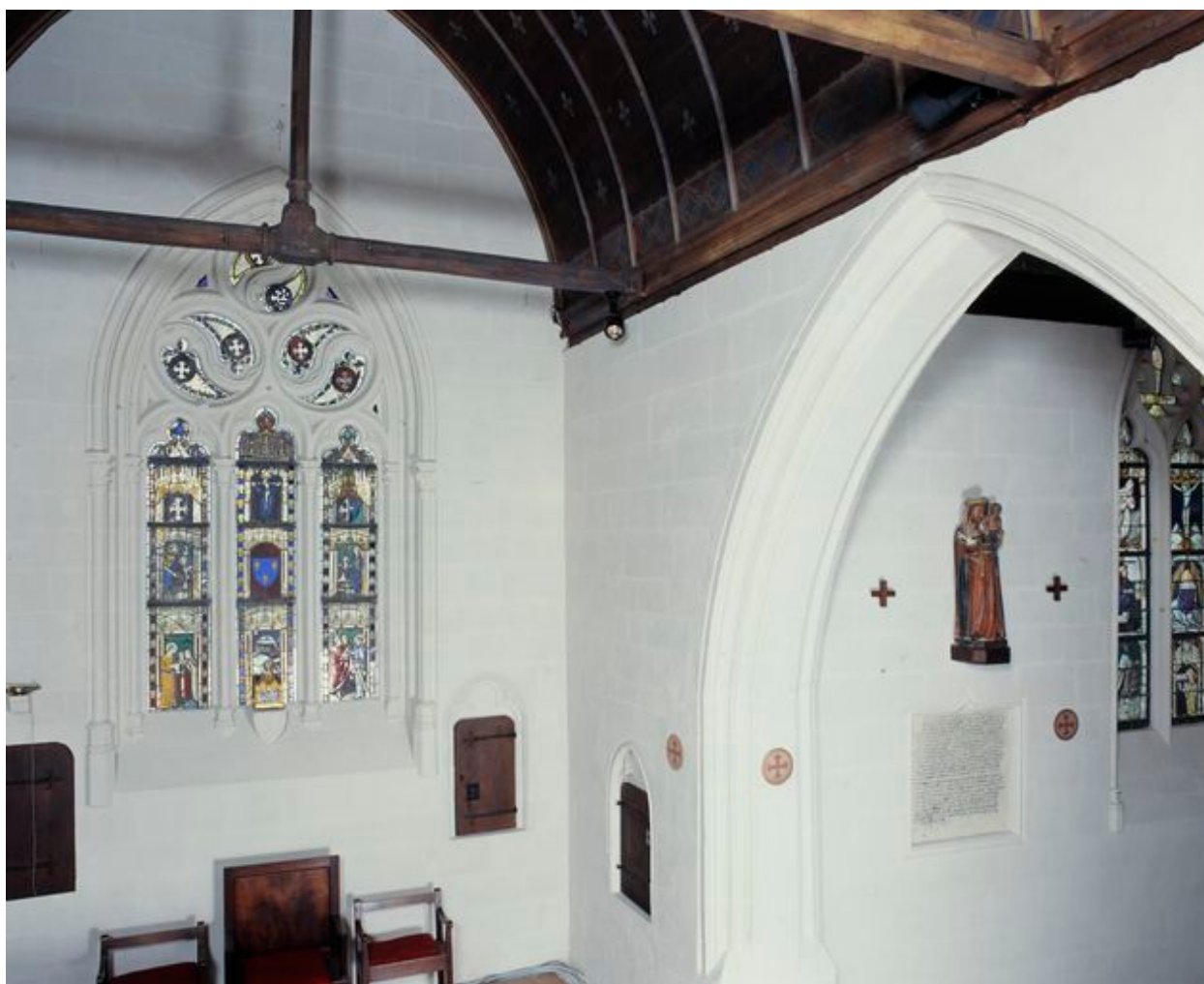
Détail de l'angle entre le choeur et la chapelle méridonale.
