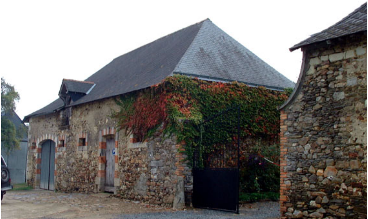
Bâtiment agricole sur le côté occidental de la cour, au nord de l'entrée.
