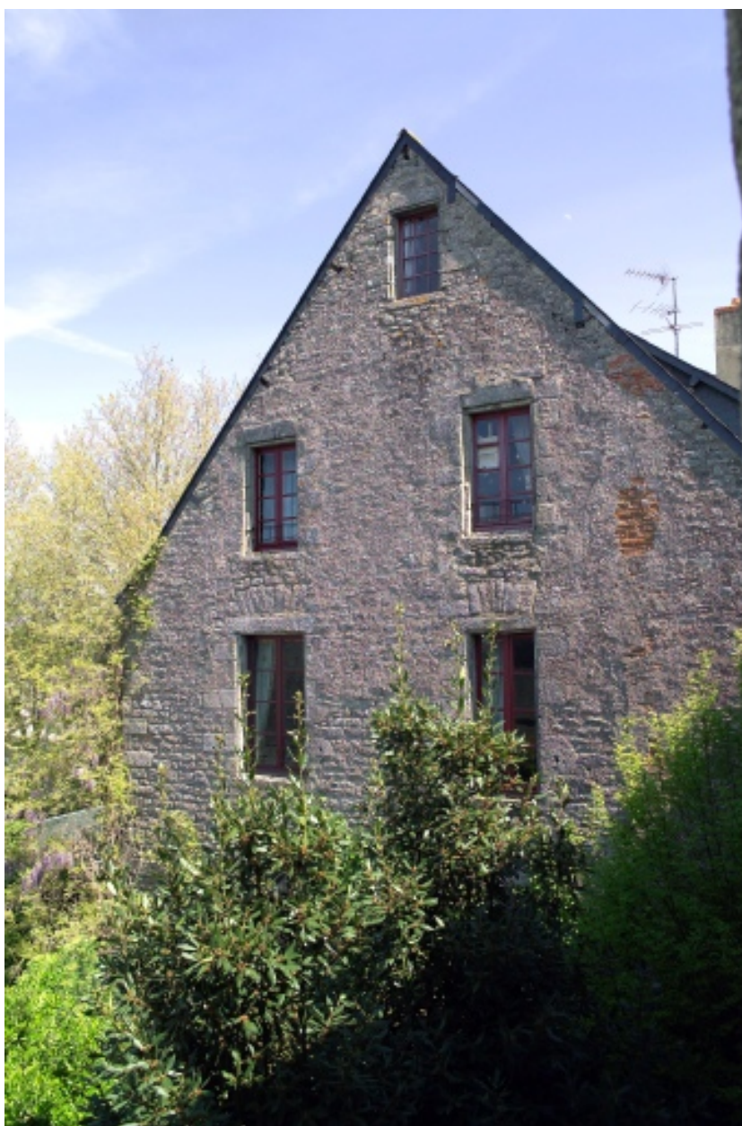
Vue du pignon de l'aile ouest.
