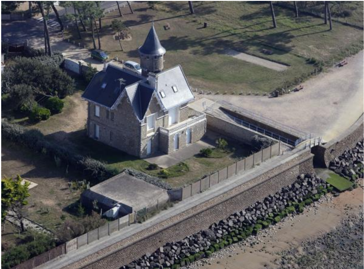
Vue aérienne de la villa depuis la côte.
