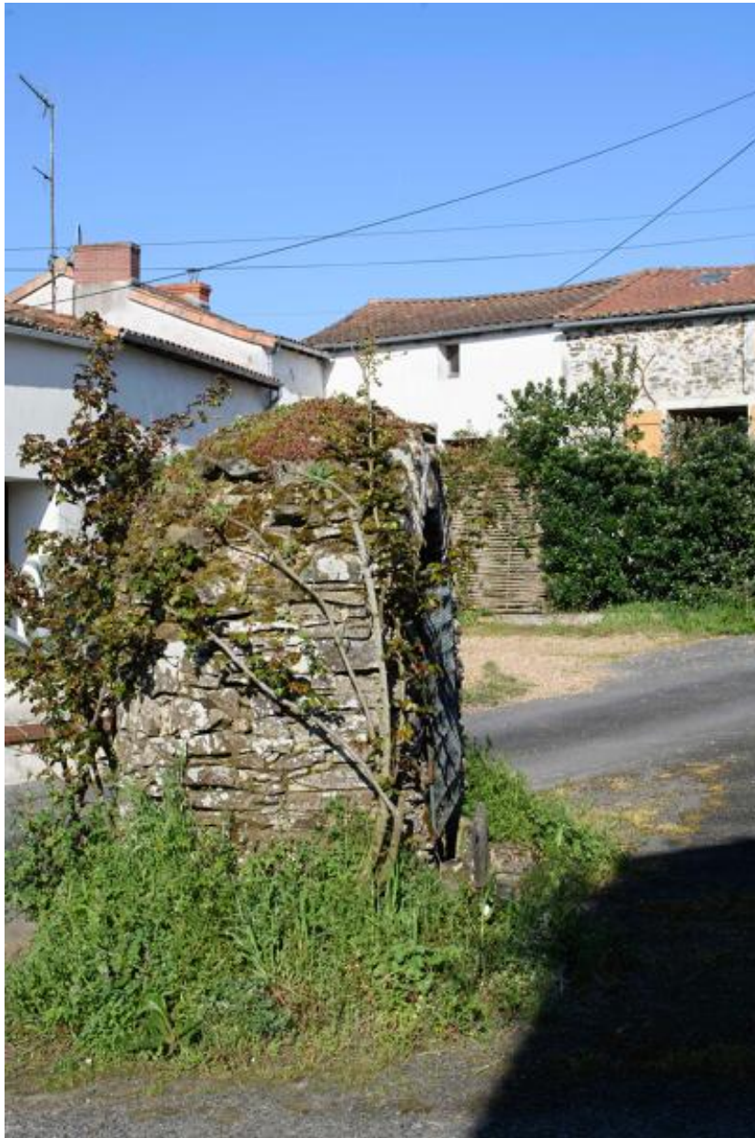
Ecart du Haut-Cimetière. Vue d'un puits commun.
