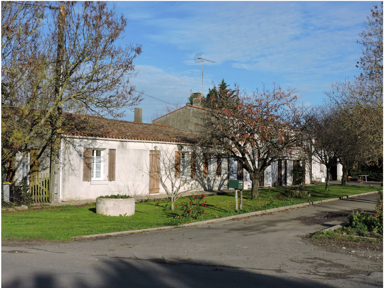
Le logis vu depuis le sud-ouest.
