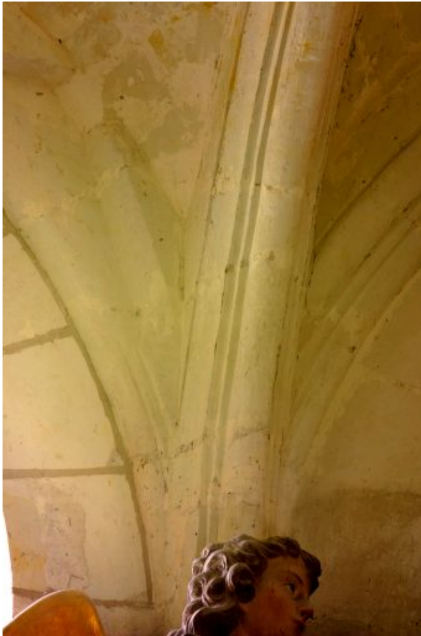
Nervure de la voûte de l'abside.
