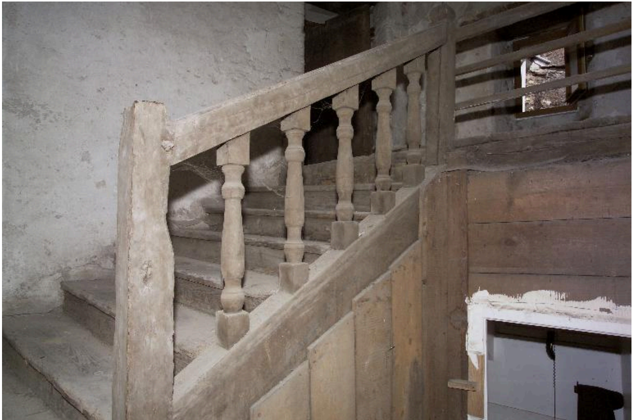
L'escalier, détail des balustres de la dernière volée.
