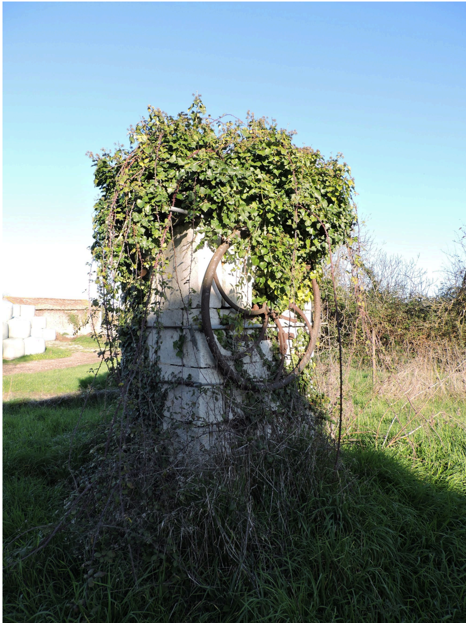
Le puits et sa pompe dans la cour au nord-est du logis.
